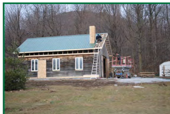
Rénovation du refuge
